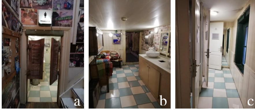
Şekil 111. 1218 Ada 5 Parselde bulunan yapının ara katında yer alan hol (a) ve ıslak hacimler (b, c)
