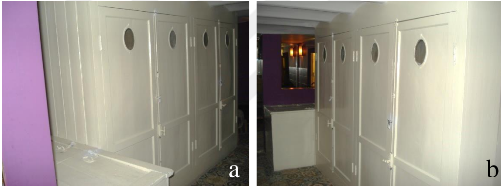
Şekil 93. 1218 Ada 7 Parselde bulunan yapının ara katında bulunan hol bölümündeki özgün giyinme dolabı (a, b)
