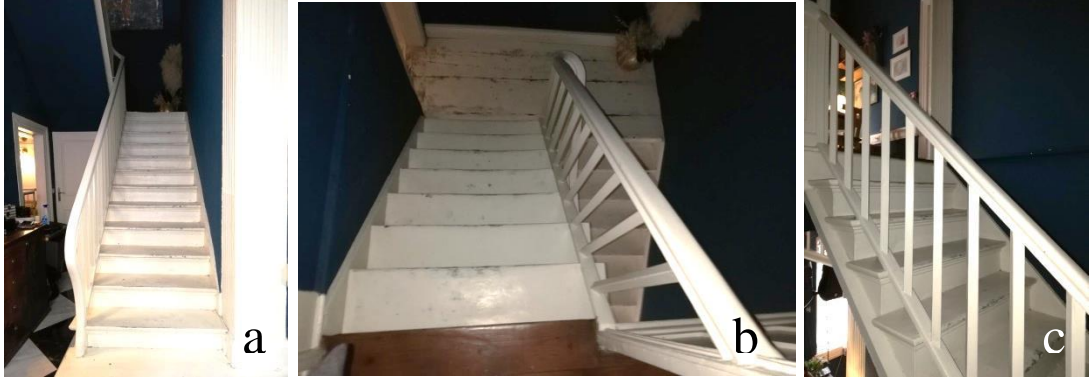
Şekil 53. 1222 Ada 12 Parselde bulunan yapının merdiveni (a, b, c)
