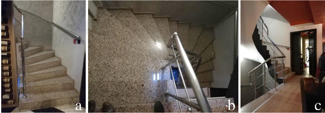
Şekil 72. 1222 Ada 10 Parselde bulunan yapının merdiveni (a, b, c)
