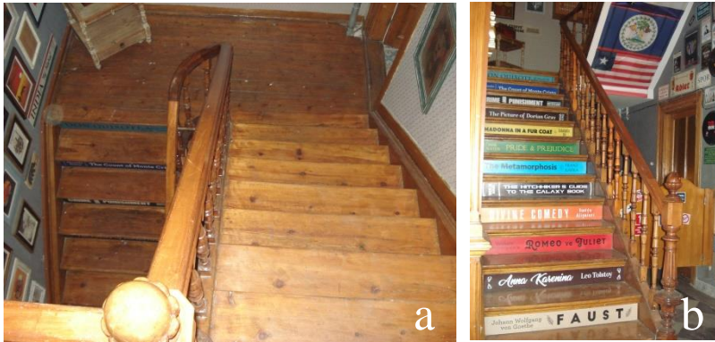
Şekil 87. 1218 Ada 7 Parselde bulunan yapının merdiveni (a, b)
