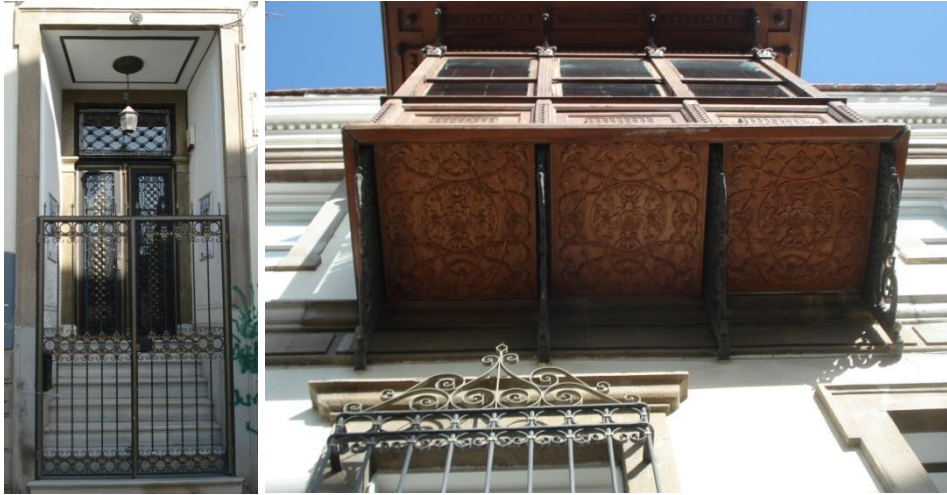
Şekil 38. 1481 Sokak No:7’de bulunan binanın kapı ve cumba detayı
