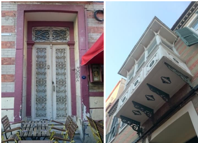
Şekil 37. Muzaffer İzgü Sokak No:4'te bulunan binanın kapı ve cumba detayı
