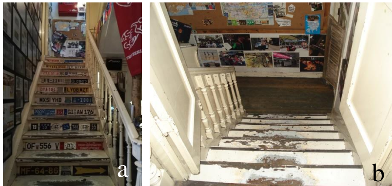
Şekil 106. 1218 Ada 5 Parselde bulunan yapının merdiveni (a, b)
