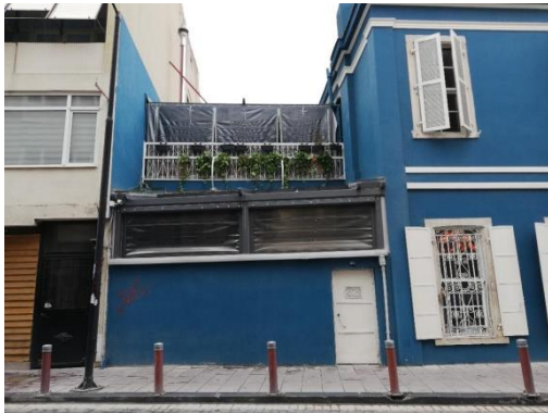
Şekil 50. 1222 Ada 12 Parselde bulunan yapının bahçe ve teras üzerinde mevcut olan tente eklentisi, Cumhuriyet Caddesi cephesi
