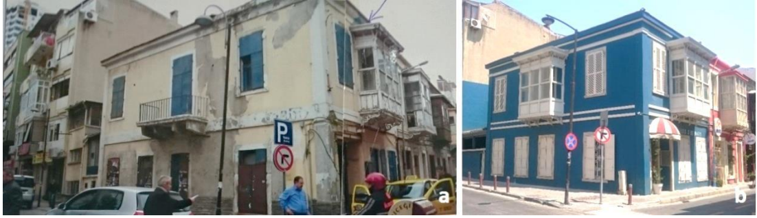
Şekil 48. 1222 Ada 12 Parselde bulunan binanın 2009 yılındaki (a) ve günümüzdeki durumu (b)
