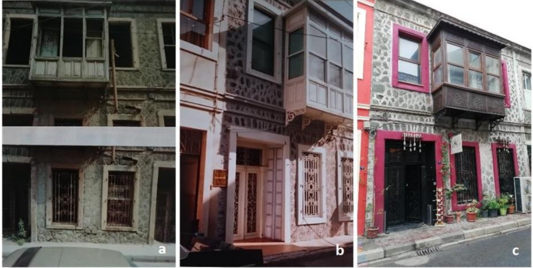
Şekil 68. 1222 Ada 10 Parselde bulunan binanın restorasyon öncesi (a), restorasyon sonrası (b) ve günümüzdeki durumu (c)
