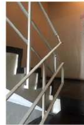
I: Stair detail
