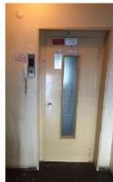
L: Elevator Door
