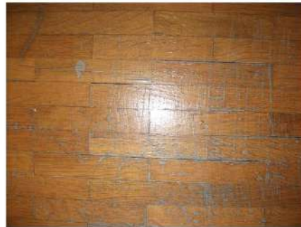
D: Floor parquet
